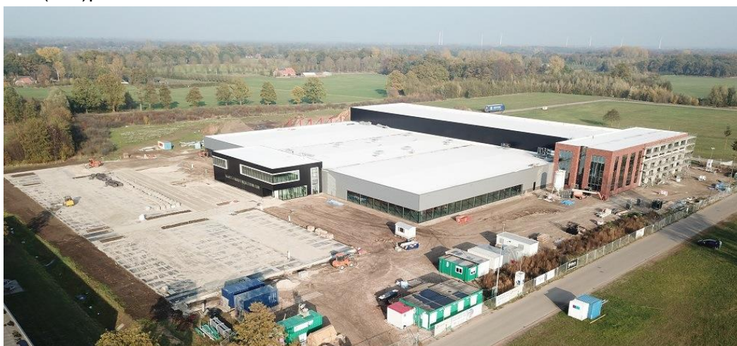
Nieuwbouw Van Raam
